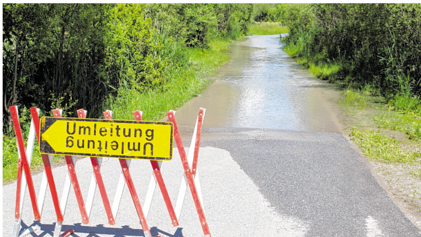
Die Zufahrtsstraße zur Knappenwelt ist zum Seitenarm der Gurgl mutiert. Durch die Kanaldeckel gelangt Wasser in das Abwassersystem. Foto: Daum
